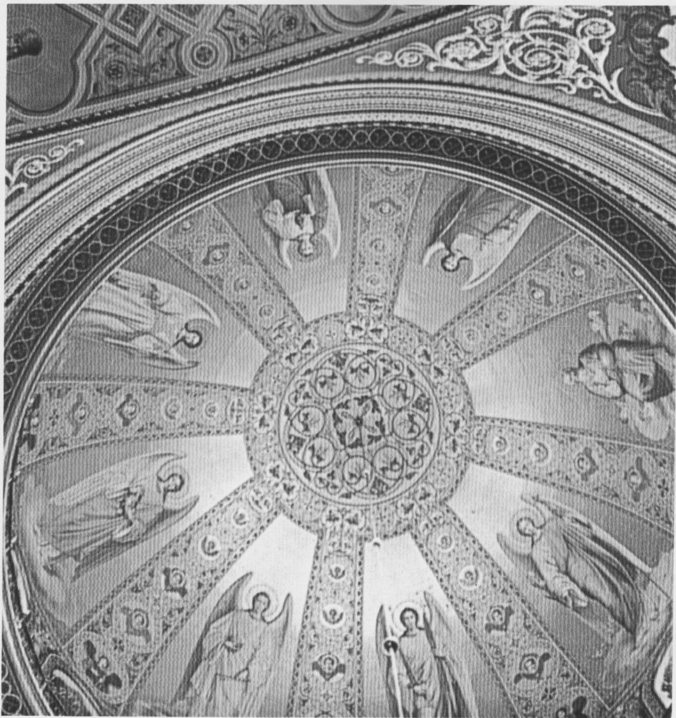
Yläkirkon vuonna 1938 uusitut kattomaalaukset.
