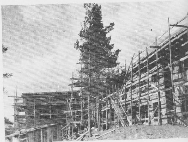
Niikkanen uusi kasarmi rakenteilla.
